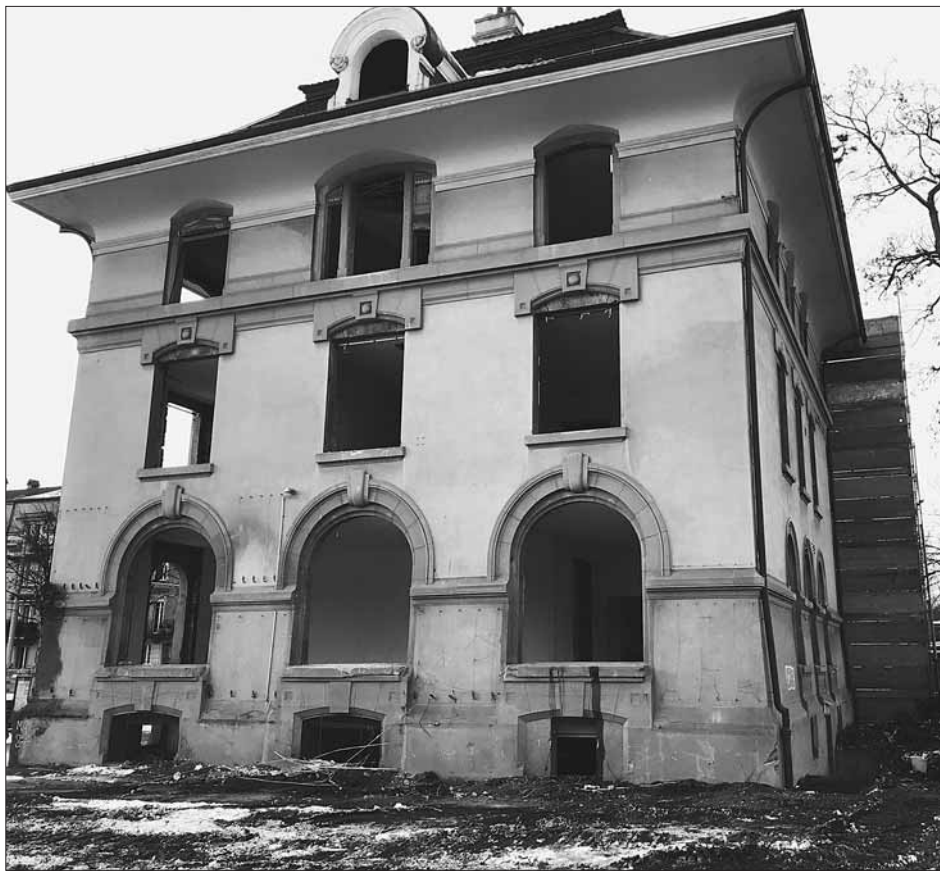
Das letzte Gebäude auf dem ehemaligen Tramdepotareal wurde im Februar 2021 abgerissen.
