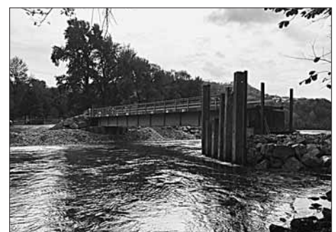
Bis gleich im Eichholz. Abkürzung über die Aare während der Uferwegsanierung.
