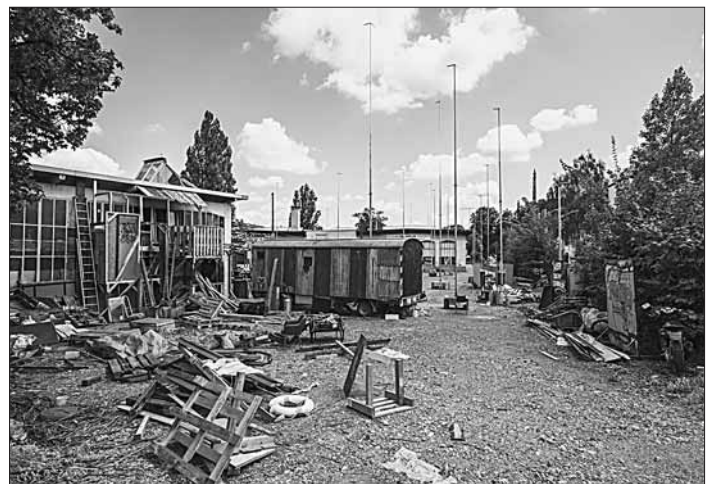
Aus der Fotoausstellung vom 1.7. bis 19.8. «Bilder von der Brache, vom Abriss und Aufbau am Bürgerziel».
