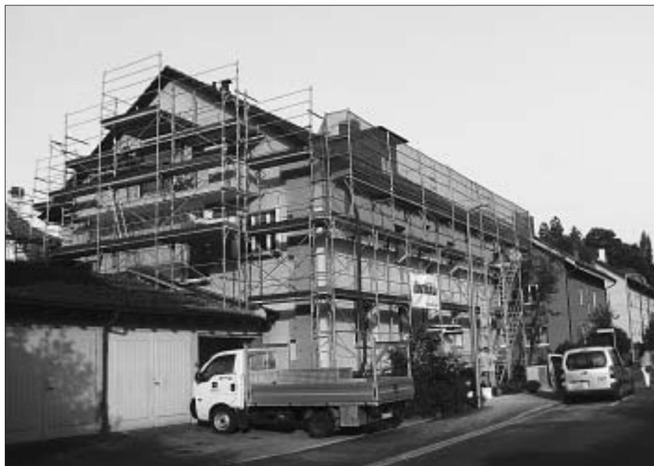
Totalsanierung mit neuen Fenstern und Wärmedämmung am Elfenaueg.
