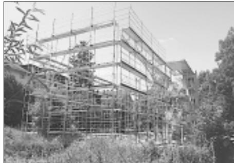
22.7.2016 – das Grundgerüst ist aufgebaut, der Erschliessungsturm mit Treppe und Lift rechts steht schon.
